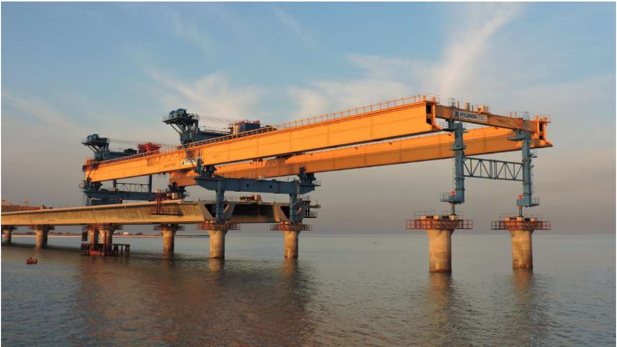
Figura 3. Lanzadera avanzada, en posición para el movimiento de los apoyos
