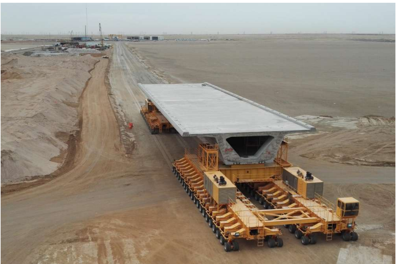
Figura 6. Transporte de elementos hasta pontona
