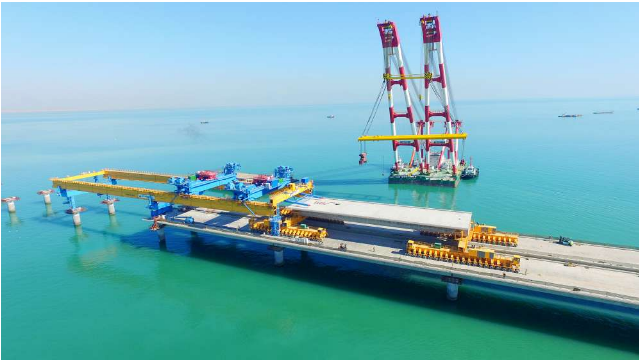
Figura 4. Lanzadera montada e iniciando los trabajos de colocación de vanos prefabricados
