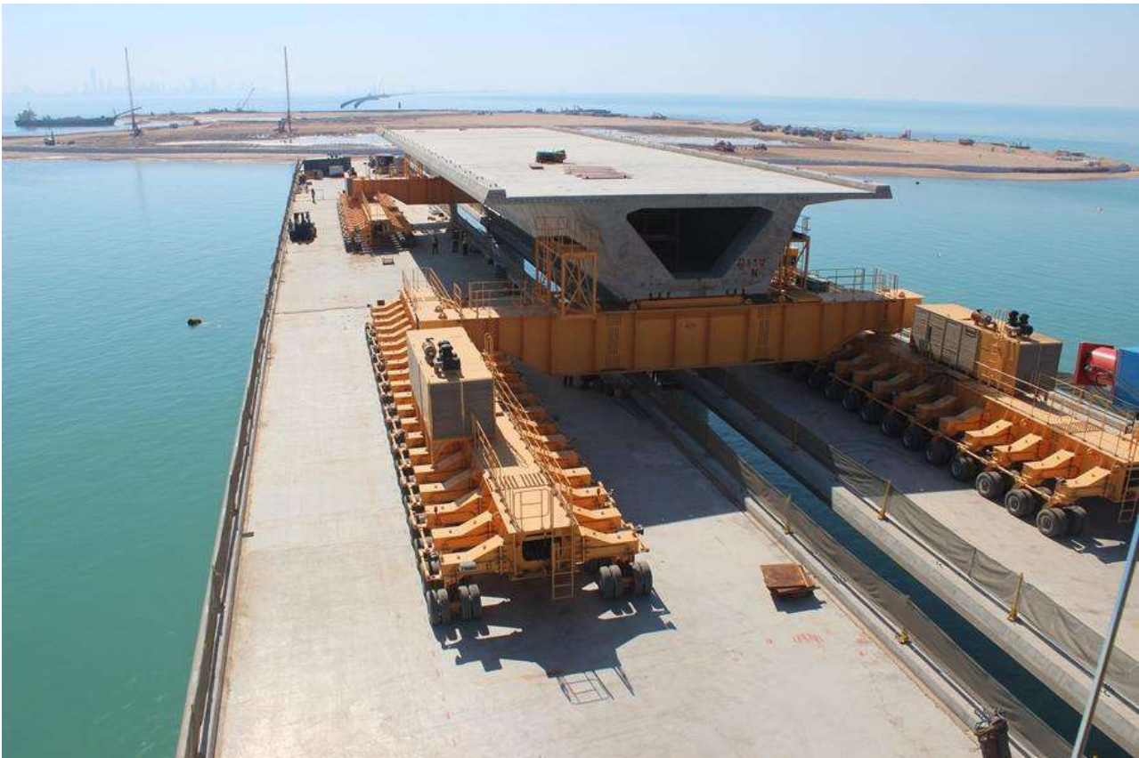
Figura 7. Transporte de cajones prefabricados sobre el tablero acabado
