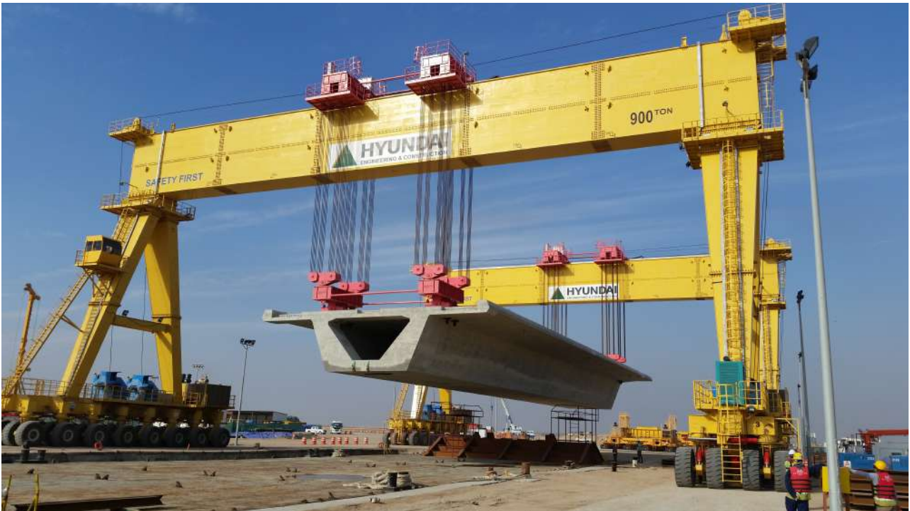
Figura 5. Recogida de vanos prefabricados en acopio
