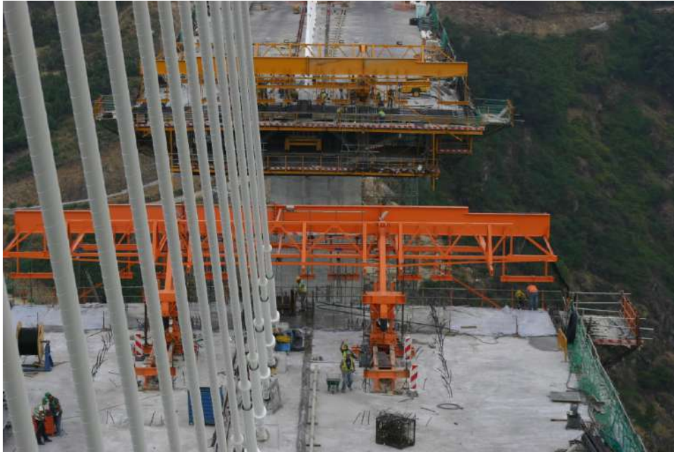
Figura 7. Vista de ambos Carros de Voladizo aproximándose a la dovela de cierre
