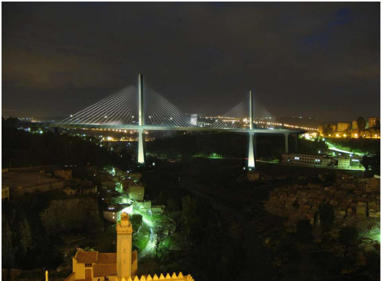
Figura 2. Viaducto Trans - Rhumel. Tramo Principal atirantado
