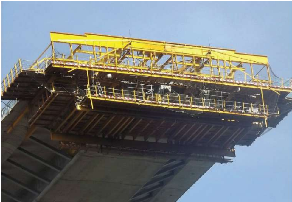
Figura 5. Carro de Voladizo - Vista Inferior
