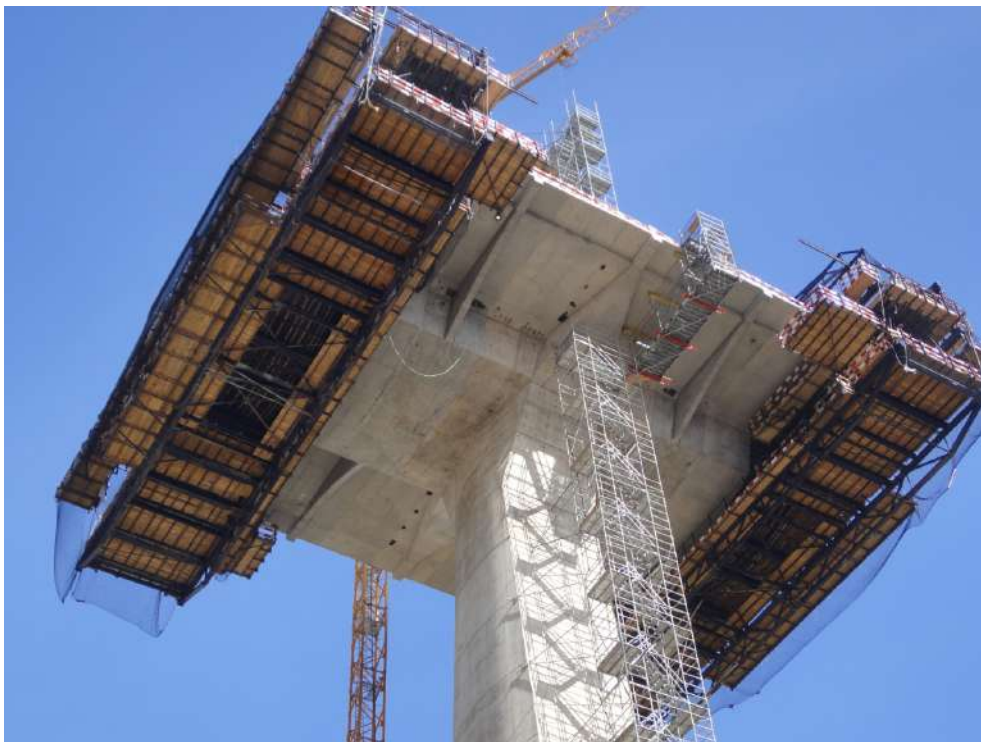
Figura 11. Vista de ambos Carros de Voladizo avanzando desde de la Pila Principal
