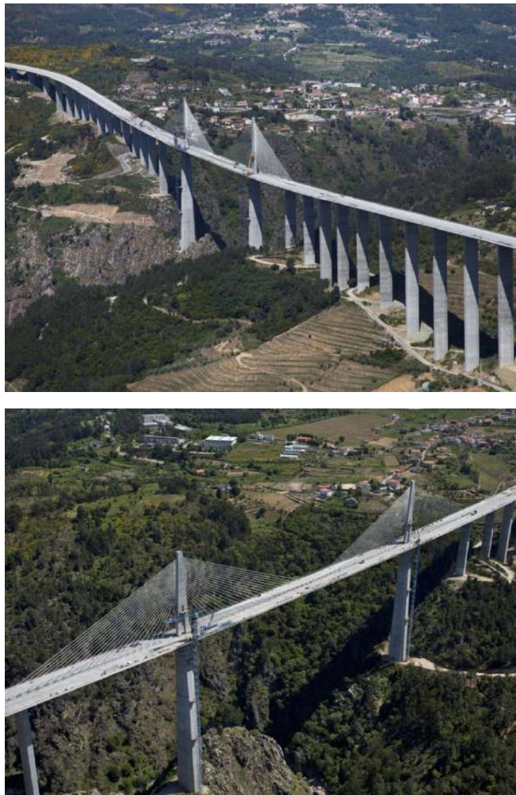
Figura 1. Viaducto del Corgo. Vista general y Tramo Principal atirantado.
