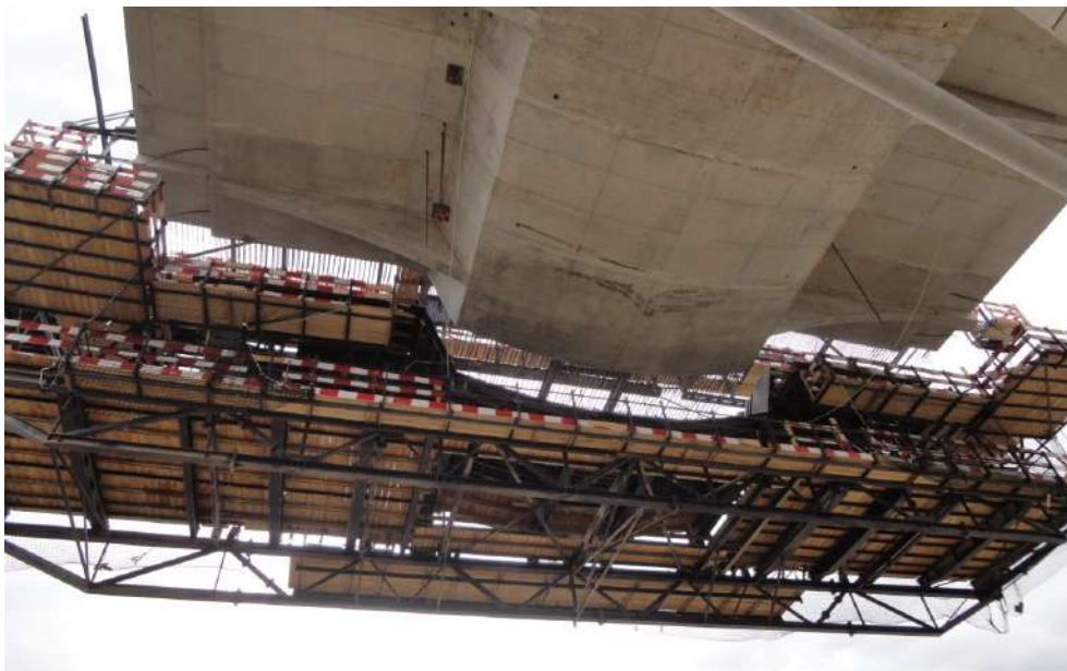
Figura 9. Carro de Voladizo - Vista Inferior
